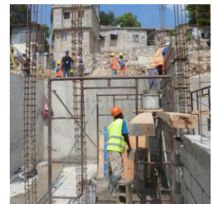
Une des 19 maisons en cours de construction dans la phase pilote à Morne Hercule, courtoisie FRH
