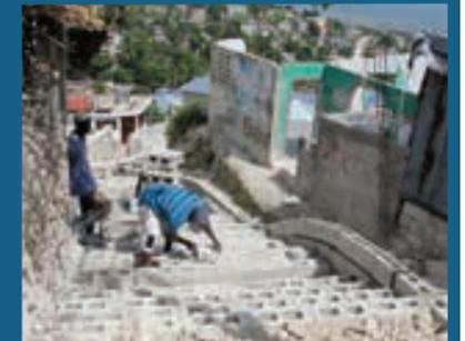
Construction des escaliers avec des adoquins recyclés. Courtoisie du FRH
