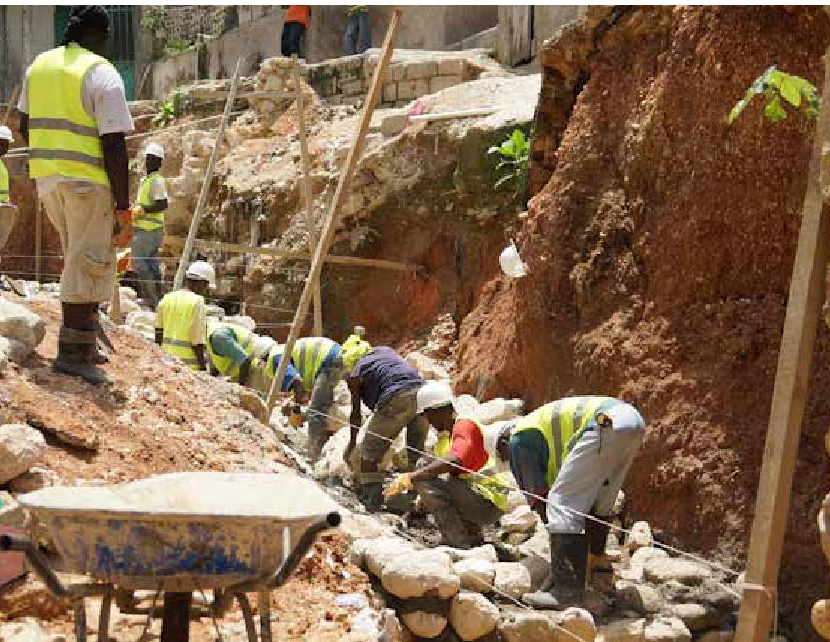
Réhabilitation d'un canal à Morne Hébo. 16 quartiers /6 Camps Photo courtoisie de l'ONU
