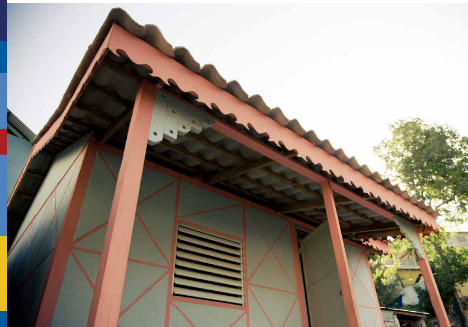
Maison parasismique à Carrefour Feuilles fabriquée à partir de débris recyclés. Projet de gestion des débris
