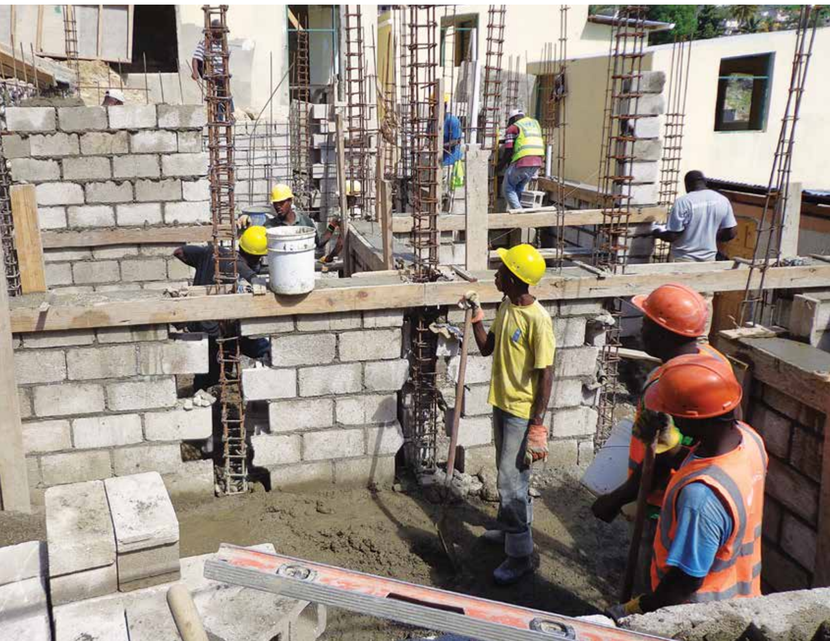
Reconstruction d'une maison démolie à Morne Hercule. 16 Quartiers/ 6 Camps
