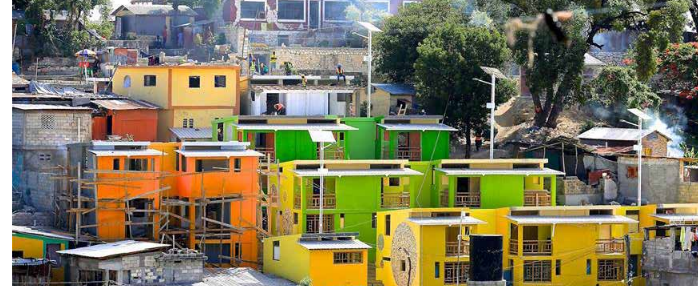
Maisons parasismiques et anticycloniques à Morne Hercule . 16 Quartiers/6 Camps
